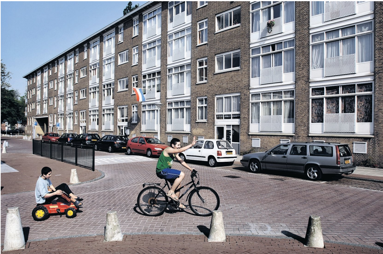
Sociale woningbouw in de wijk Bos en Lommer in Amsterdam-West. Voor de bouw van sociale huurwoningen kunnen corporaties goedkoop met staatssteun blijven lenen. Maar voor duurdere huurwoningen en koopwoningen wil minister Donner een commercieel tarief invoeren. Foto Joost van den Broek / de Volkskrant
